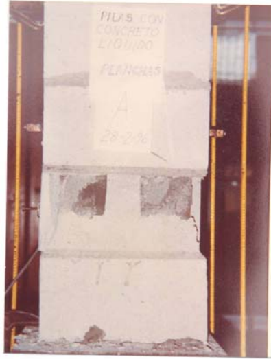
Fig.4. Pila Rellena con Mortero Líquido Con Planchas.
