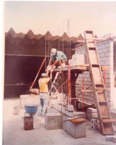
Fig.10. Construcción de MG4 con Reforzo Vertical Continuo.
