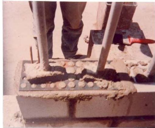
Fig.6. Planchas en el Muro MG4.
