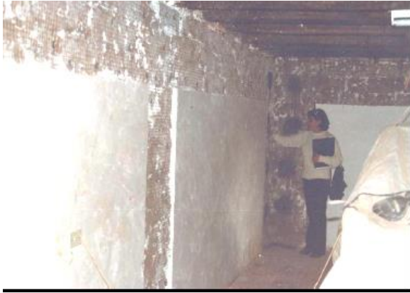
Fig.10. Eliminación del tarrajeo.
