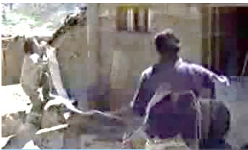
Fig.13. Instalación de la malla y fijación con clavo y chapa.
