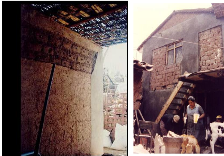
Fig.16. Tarrajeo de la malla con mortero 1:5.
