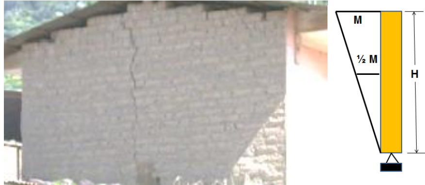
Fig.6. Propagación de la falla por flexión en el centro del muro y variación del momento flector "M" en la altura.
