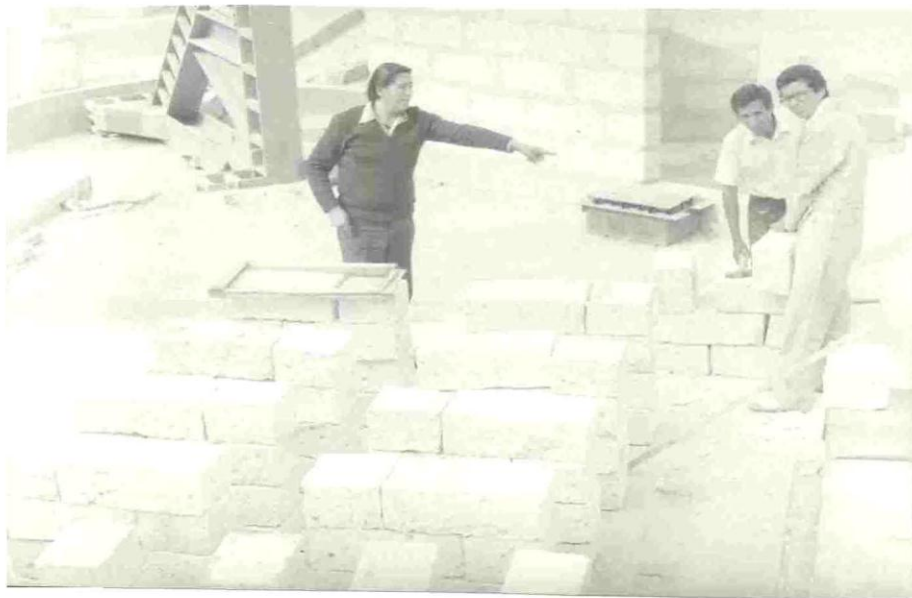
FOTO N° 12 PREPARACION DE LAS UNIDADES COMPONENTES DE LOS MURETES Y MUROS A ENSAYAR
