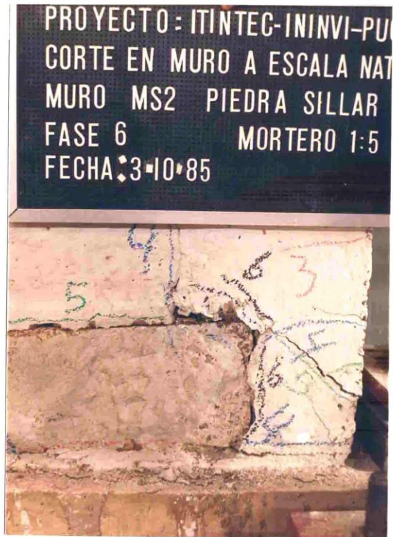
FOTO N° 29 ESTADO FINAL DE LA COLUMNA DERECHA, ZONA INFERIOR ES NOTORIO EL DESPLAZAMIENTO DEL BLOQUE Y SU SEPARACION DE LA COLUMNA .
