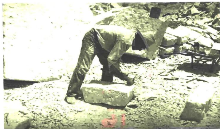
FOTO Nº 5 REFINADO FINAL DEL BLOQUE
