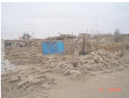
Fig. 5.- Viviendas tradicionales de adobe en Ica, con colapsos por doquier. (Créditos: Angel San Bartolomé, 2007)
