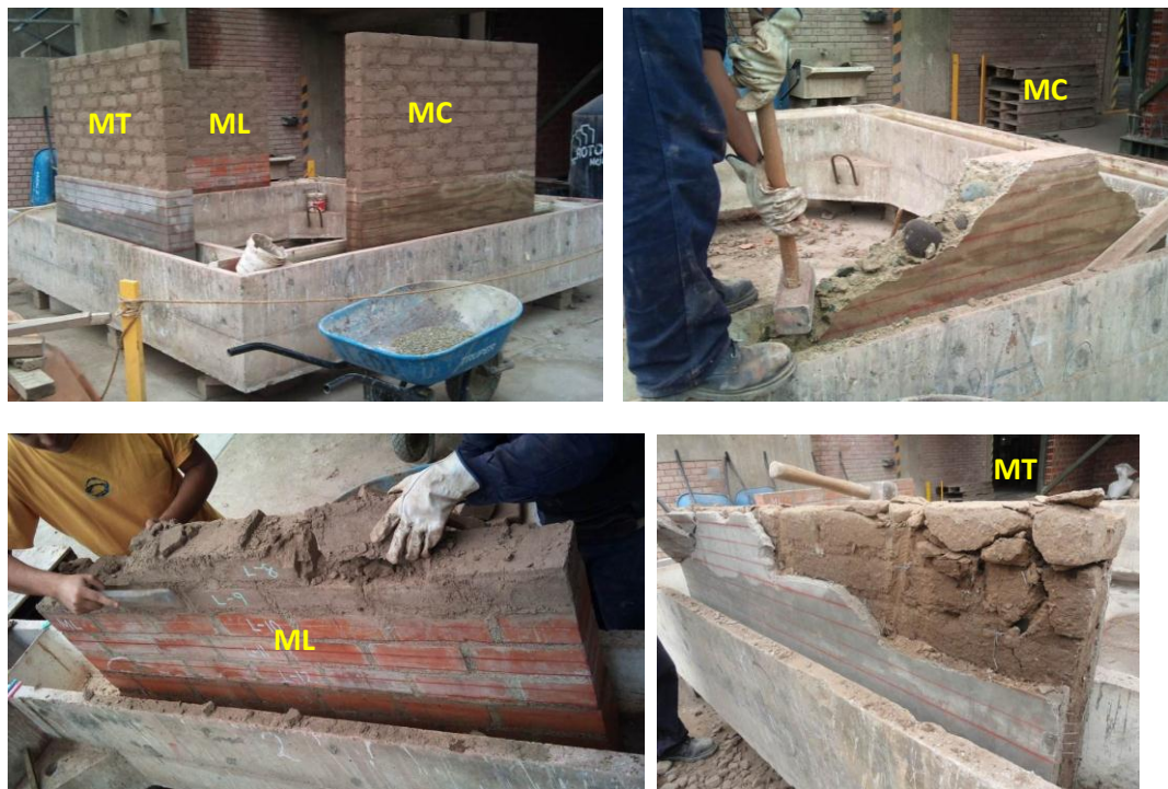
Fig.7- Estado final de los muros MC, ML y MT tras 24 días de inundación y estado de los adobes localizados en la base de los muros.
