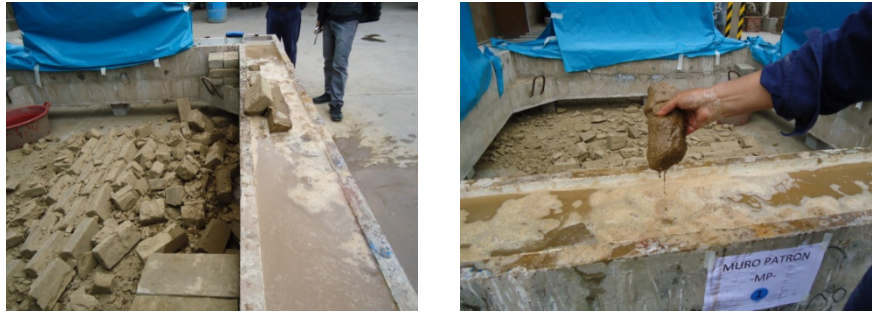
Fig.10 Volcamiento del muro MP y estado de los adobes en la base.
