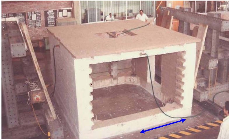
Fig.6. Ensayo sísmico complementario eliminando los muros de adobe de los ejes A y B.
