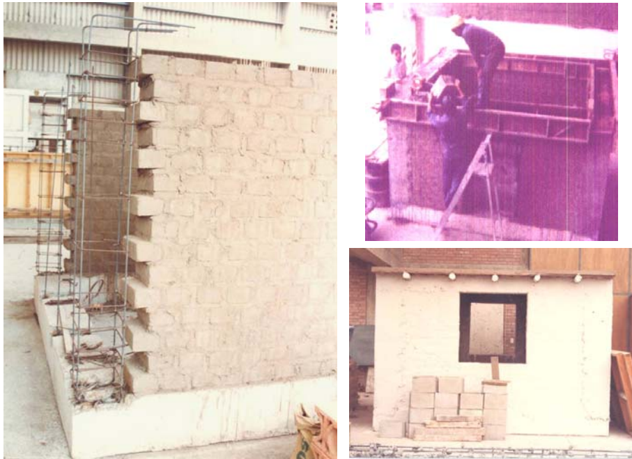
Fig.2. Construcción del Módulo de Adobe Confinado.
