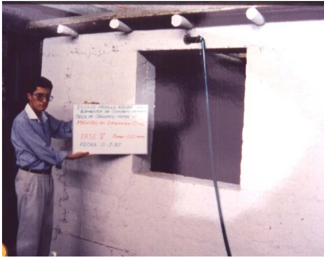
Fig.4 Fisuras en la Fase 5. Eje B.
