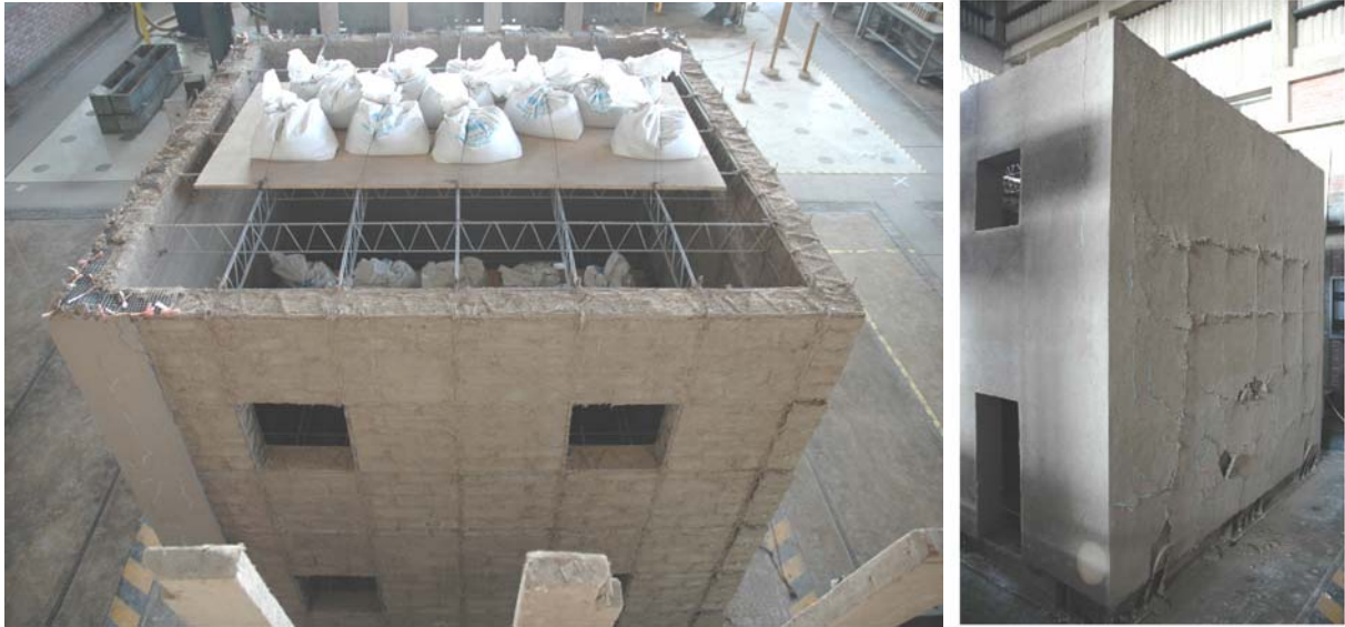
Fig. 6: Fotografías de las grietas después del 4º ensayo (130 mm); a) Side without rendering; b) Side with rendering.
