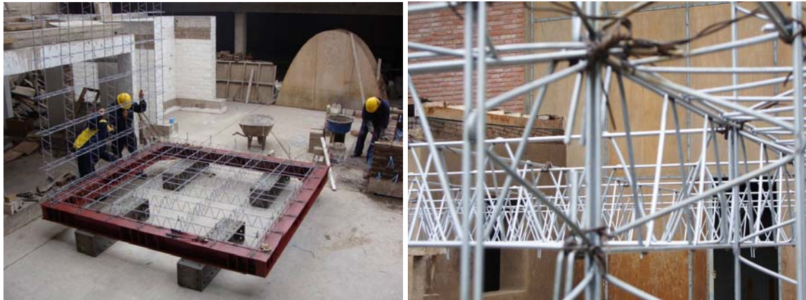
Fig. 3: a) Construcción del anillo perimetral de 3 m x 3 m; b) Unión en obra de las cerchas con alambre
