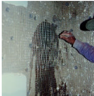
Figura 3. Etapas del reforzamiento en viviendas existentes. Eliminación del tarrajeo y perforaciones en el muro (izquierda), instalación de conectores y malla (centro) y tarrajeo final (derecha).
