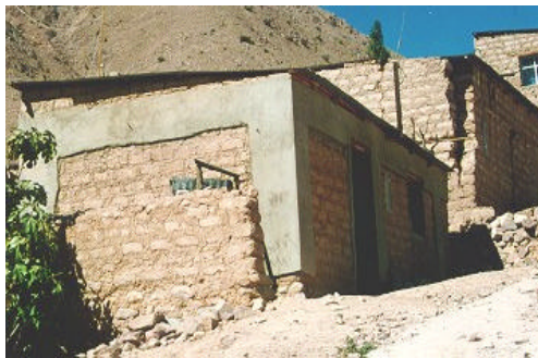
Figura 5. Viviendas reforzadas en 1998 en Moquegua, después del sismo del 2001. Las viviendas vecinas con fuertes daños carecían de refuerzo.
