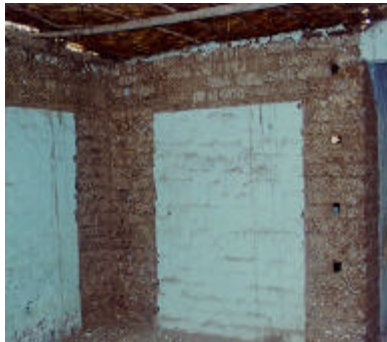
Figura 3. Etapas del reforzamiento en viviendas existentes. Eliminación del tarrajeo y perforaciones en el muro (izquierda), instalación de conectores y malla (centro) y tarrajeo final (derecha).
