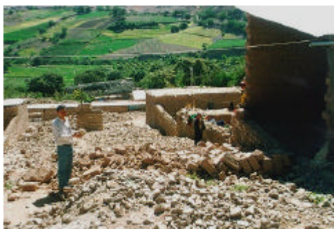
Figura 6. Colapso total y daños severos producidos por el sismo del 2001 en las viviendas de adobe carentes de refuerzo en Moquegua.
