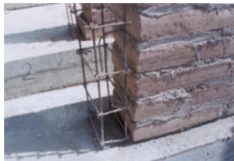
Foto 4. Conexión a ras en M3, con la adición de chicotes cada cuatro hiladas.
