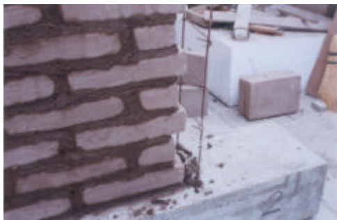
Foto 3. Conexión dentada en M2.
