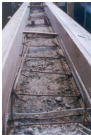
Foto 5. Viga solera.
