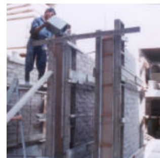
Foto 6. Construcción de los muros.
