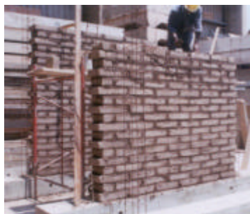
Foto 4. Conexión a ras en M3, con la adición de chicotes cada cuatro hiladas.
