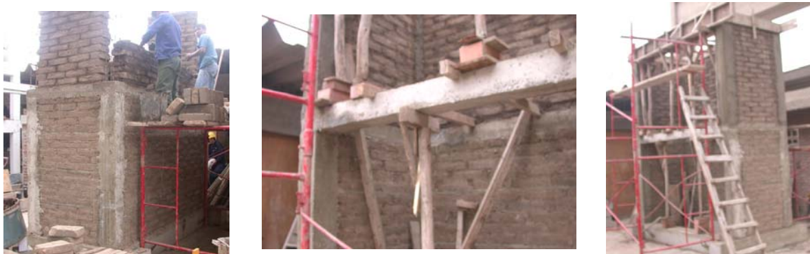
Fig.6. Secuencias de la construcción del segundo piso. En la vista central puede notarse las vigas de madera tallada empleadas en cada nivel.
