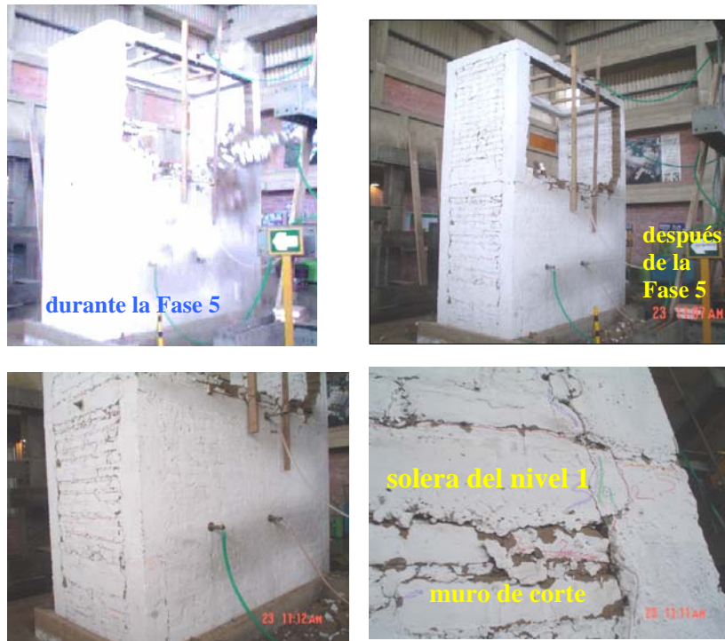
Fig.12 Estado del Módulo en la Fase 5.
