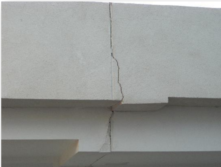
Foto 3.2. Identificación de Grietas, en la vivienda V-9 (Mza G- Lote 18) de la Urb. Trapecio. La presencia de estos daños, son en menor proporción, comparándolos con otras viviendas.
