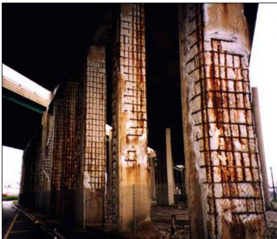
Figura 1.1 – Fotografía de un conjunto de columnas que soportan una losa de un puente. Se pueden observar grietas producto de la corrosión del acero
