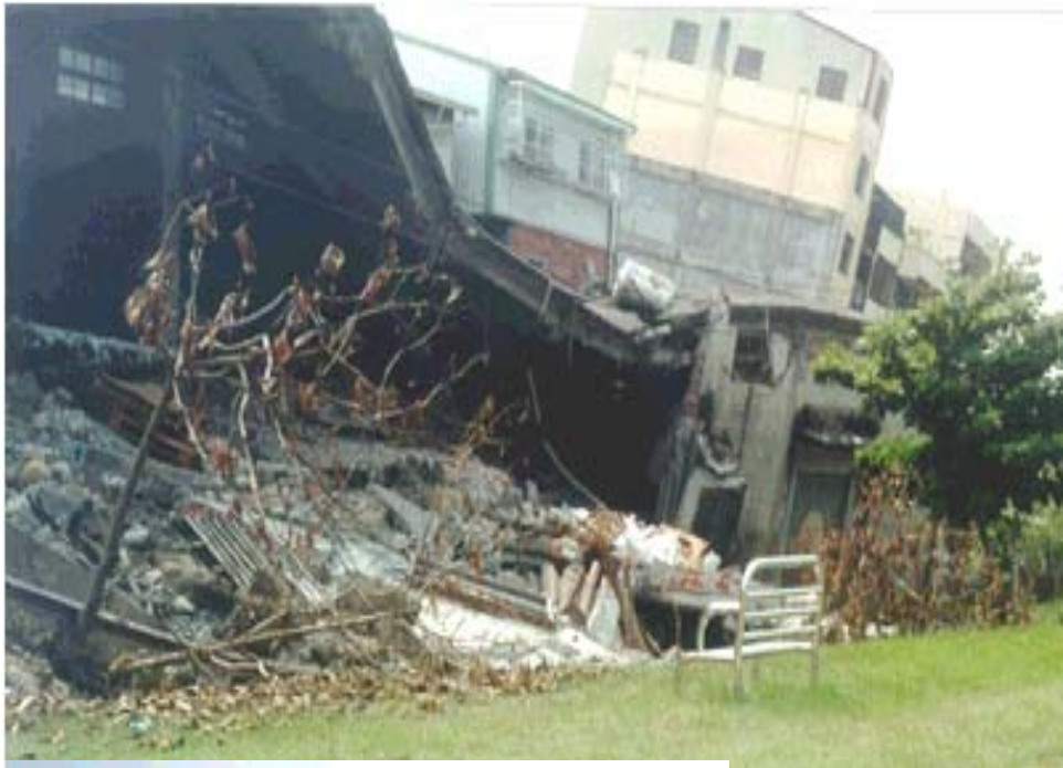
Fallas que atraviesan estructuras
