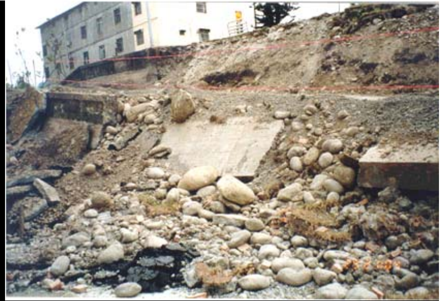
Fallas que atraviesan estructuras
