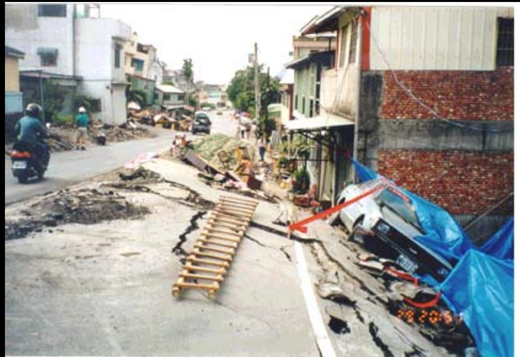
Fallas que atraviesan estructuras
