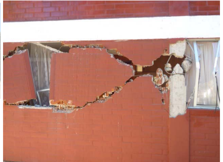
Cauquenes, “Albañilería No Confinada”
