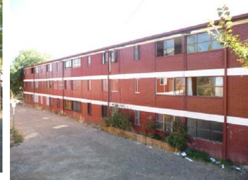
Cauquenes, “Albañilería No Confinada”
