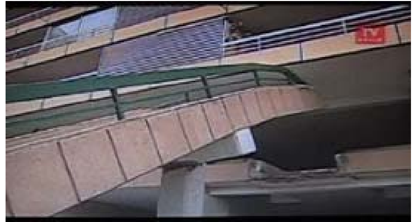
Residencial Bilbao, Santiago. Colapso de estacionamiento. Fuente: TV-Chile.
