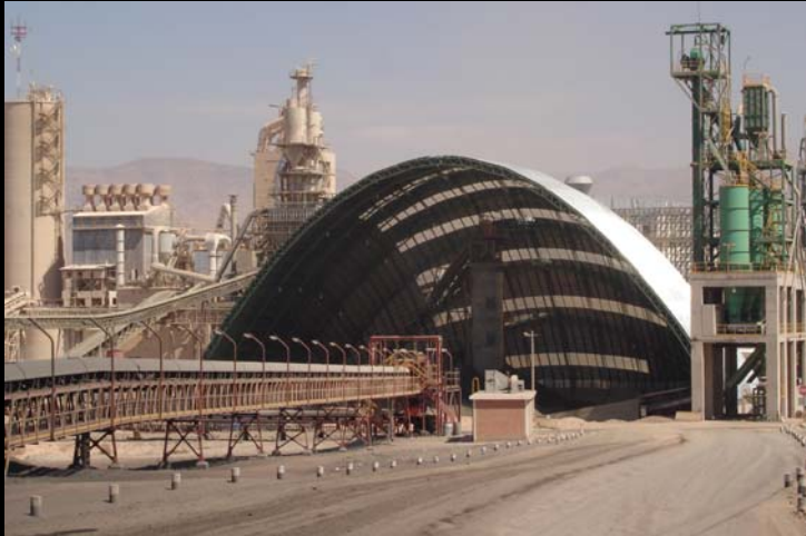
• VISTA GENERAL DE LA PLANTA DE YURA EN AREQUIPA
