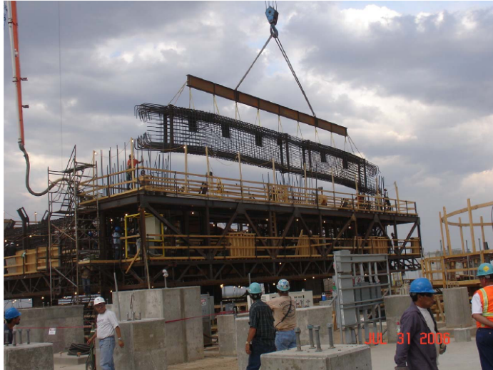
MONTAJE DEL ACERO DE REFUERZO
