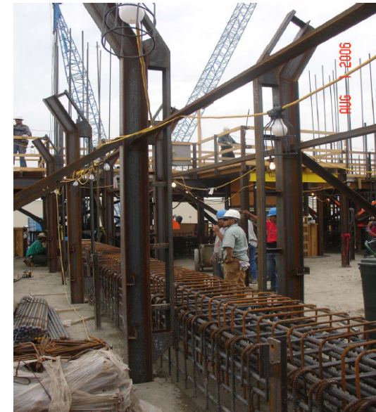
MONTAJE DEL ACERO DE REFUERZO
