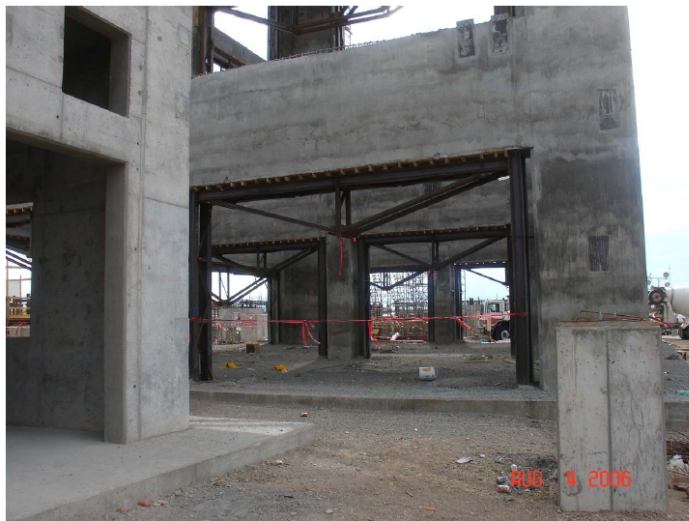
SOPORTE TEMPORAL PARA VIGAS
