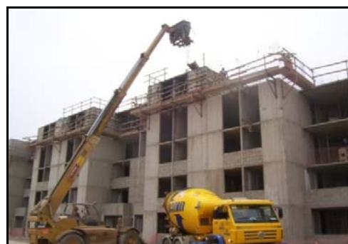
Foto 15.- Vaciado con brazo Telescópico (Telehandler)
