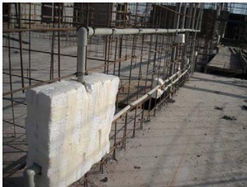
Foto 9.- Llaves de agua del dpto. Colocadas antes del vaciado.
