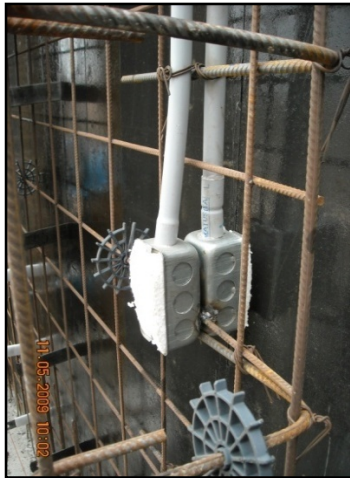
Foto 7.- Caja Eléctrica sujeta a la malla electrosoldada
