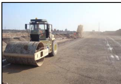
Foto 3.- Compactación en capas de 30 cm.
