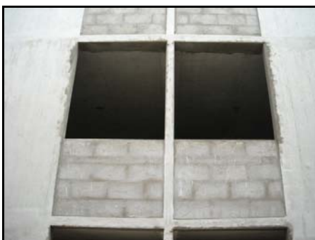
Foto 22.- Reparación de derrame de ventanas
