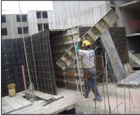
Foto 11.- Traslado rápido y fácil de Formaletas de Encofrado
