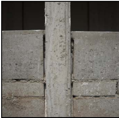
Foto 17.- Separación de ½" con tecnopor entre MDL y Ladrillo
