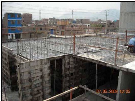
Foto 13.- Encofrado Monolítico (Muros y Losas)
