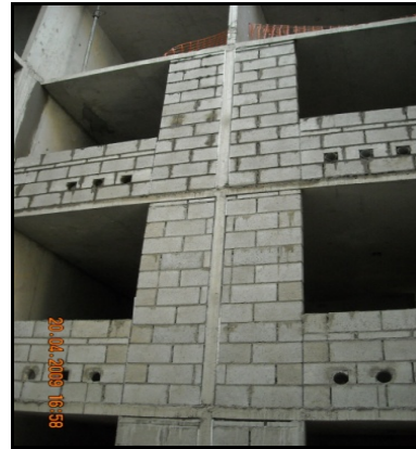
Foto 18.- Fachada con Ladrillo de concreto vibrado P-9
