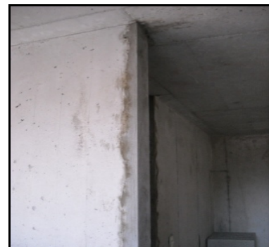
Foto 24.- Reparación de derrame de puertas
