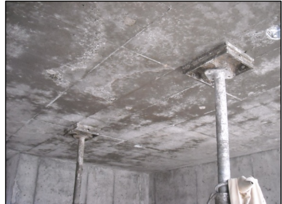
Foto 12.- Losa puntal luego del desencofrado
