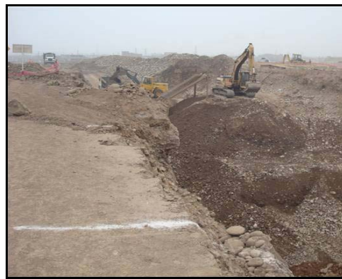
Foto 2.- Corte y Zarandeo del material Granular
