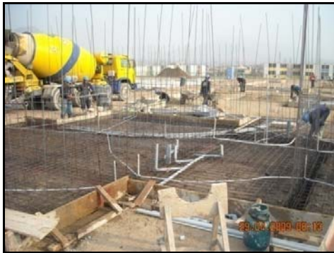
Foto 5.- Vaciado de plateas Sector 1
