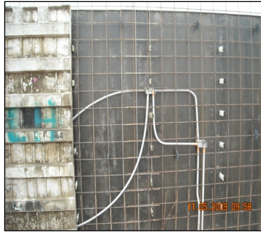
Foto 8.- Distribución de tuberías Eléctricas
