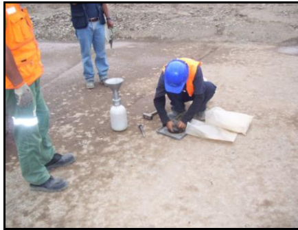
Foto 4.- Pruebas de Compactación
