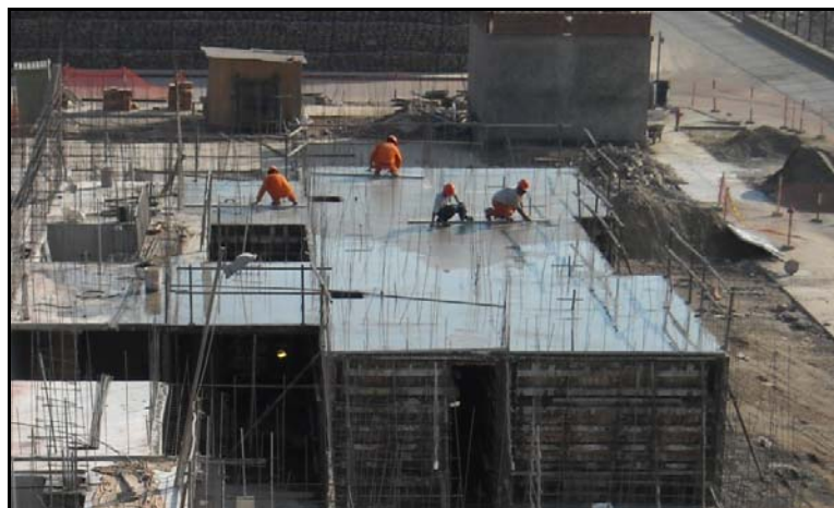
Foto 16.- Acabado de Losa Semipulido
