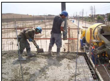
Foto 14.- Vaciado con bomba Unicon
