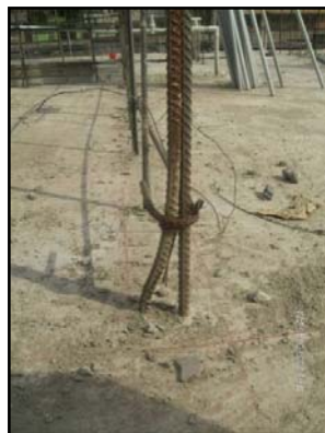
Foto 21.- Grifado de acero vertical
