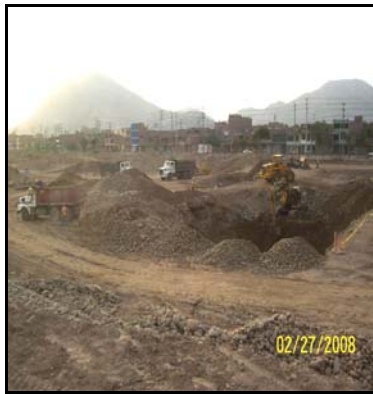
Foto 1.- Corte, Zarandeo y Traslado del Relleno de Ingeniería
