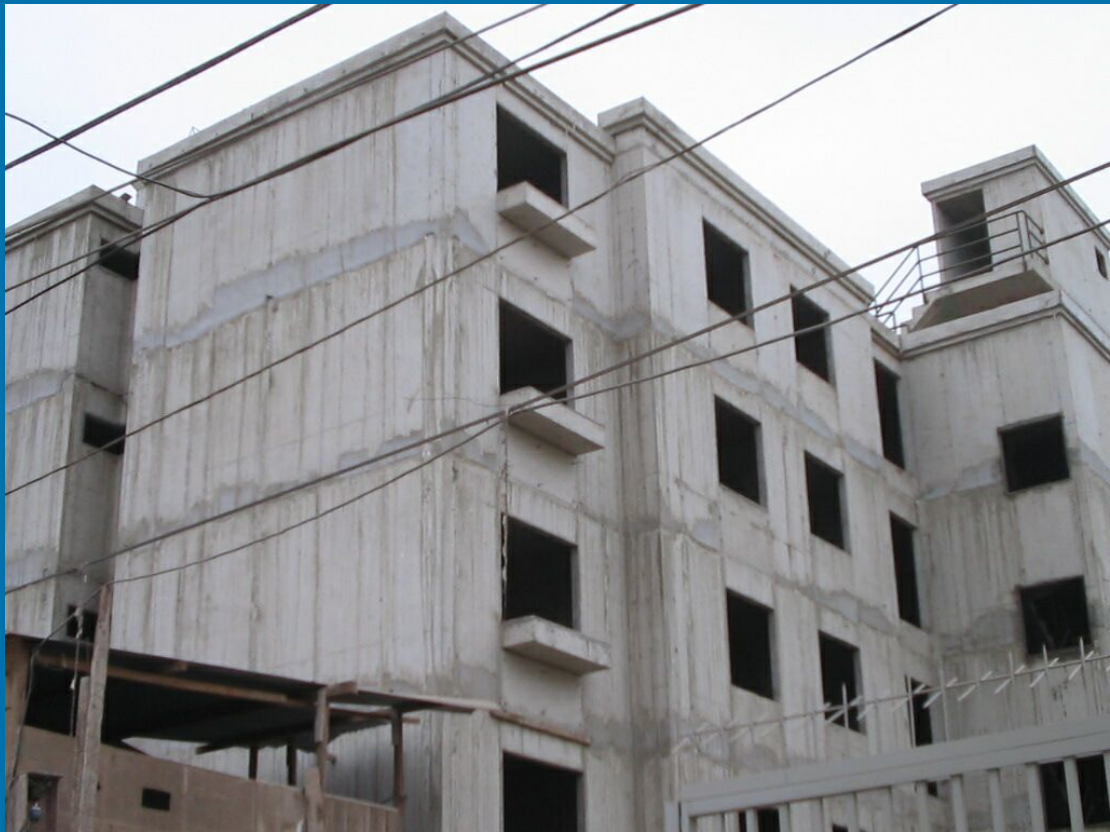
Solo muros estructurales
