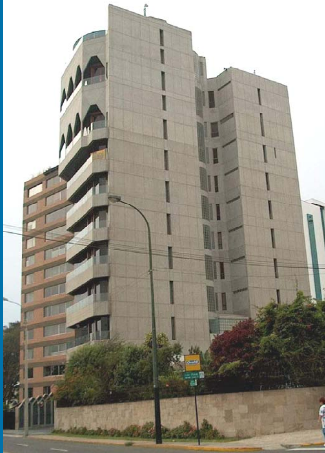
Con muros estructurales
