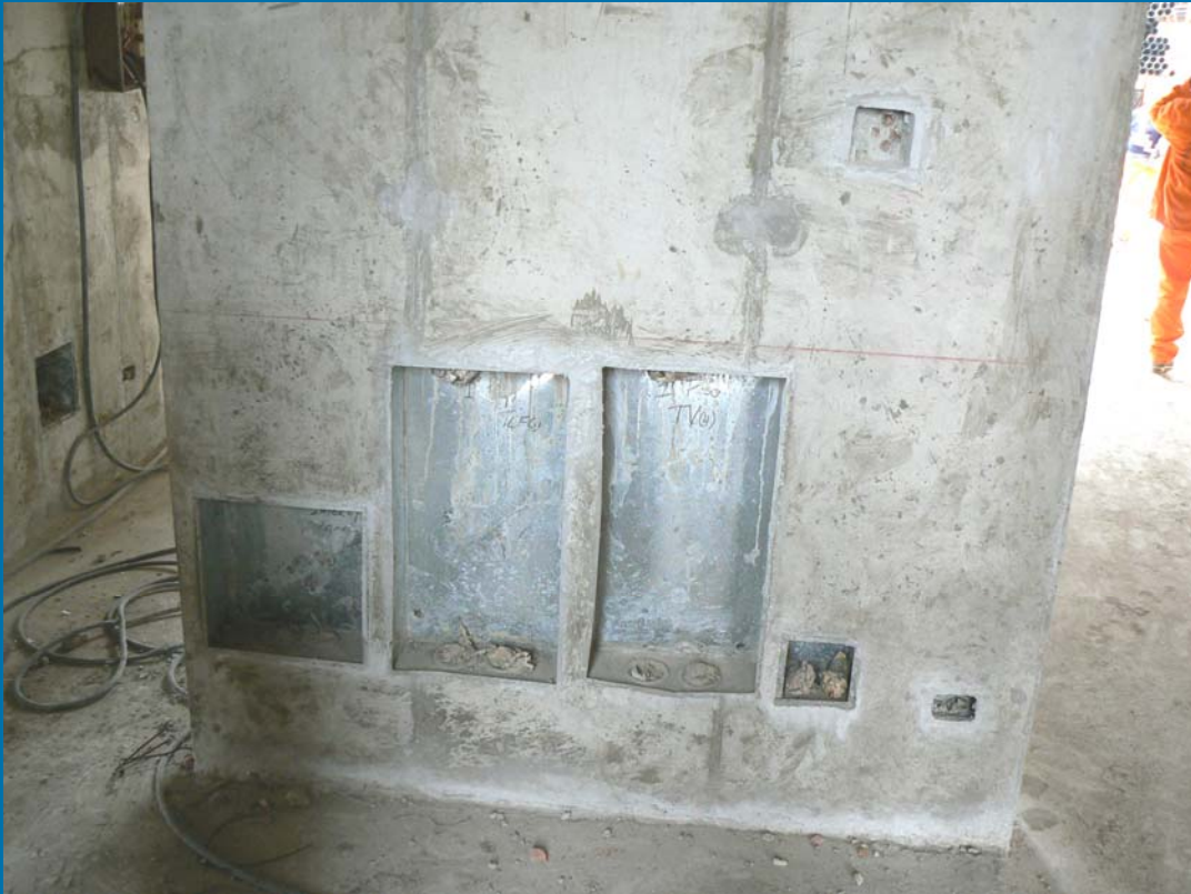
Ductos y cajas para instalaciones eléctricas. Del muro de concreto no quedó nada
