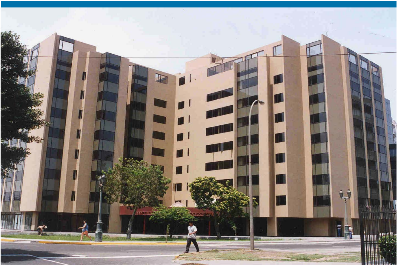
Muros estructurales y pórticos
