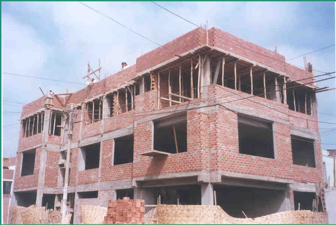
Aporticado con muros de relleno
