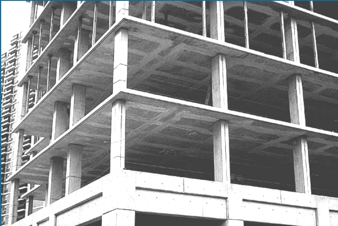
Edificio con losas sin vigas
