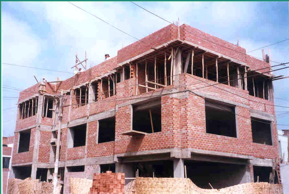
Aporticado con muros de relleno
