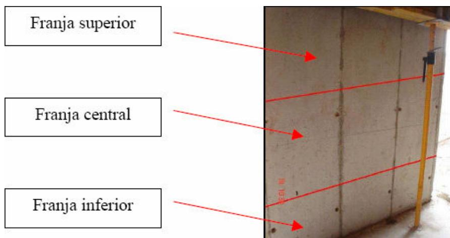
**Foto N° 1 .- División del muro en franjas horizontales**
