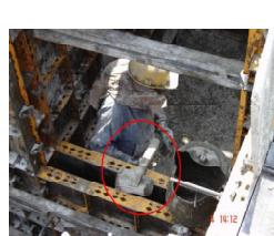
5) Vibración externa de encofrado para eliminación de burbujas
