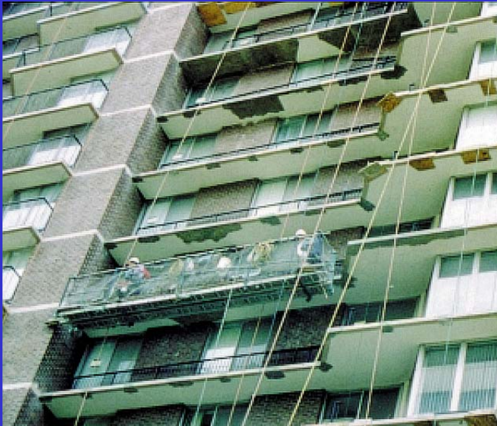
Volados Expuestos a la brisa marina
