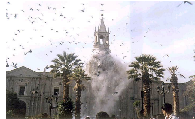
INSTANTE EN QUE SE INICIA LA FALLA DE LA TORRE DERECHA DE LA CATEDRAL DE LA CIUDAD DE AREQUIPA (FOTO INTERNET)
