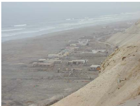
RESTOS DE VIVIENDAS AFECTADAS POR EL INGRESO DEL AGUA DEL MAR FOTO EDUARDO FIERRO (CIP)
