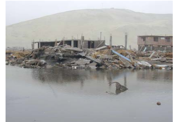
RESTOS DE VIVIENDAS AFECTADAS POR EL INGRESO DEL AGUA DEL MAR FOTO EDUARDO FIERRO (CIP)
