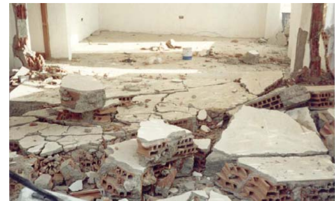
LADRILLO TUBULAR CON ABUNDANCIA DE PERFORACIONES FOTO ALEJANDRO MUÑOZ (CIP)
