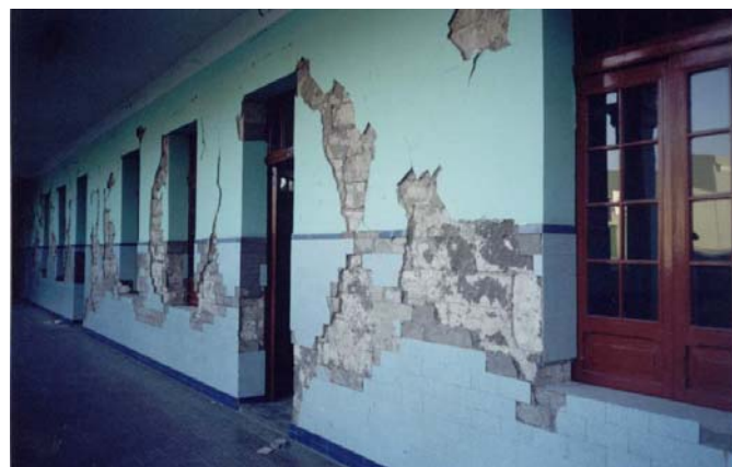
COLEGIO LA SALLE: CONSTRUIDO EN 1930 CON COLUMNAS DE CONCRETO Y MUROS DE SILLAR FOTO ANTONIO BLANCO (CIP)
