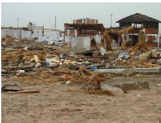
RESTOS DE VIVIENDAS AFECTADAS POR EL INGRESO DEL AGUA DEL MAR FOTO EDUARDO FIERRO (CIP)
