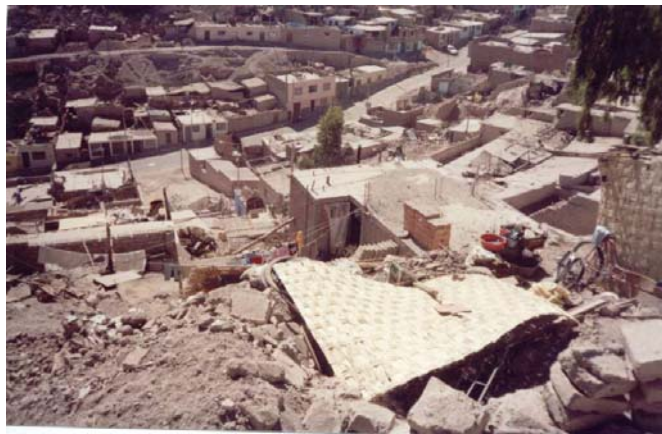
VIVIENDAS UBICADAS EN EL CERRO SAN FRANCISCO CON SERIOS DAÑOS FOTO JESUS ABUGATTAS (CIP)
