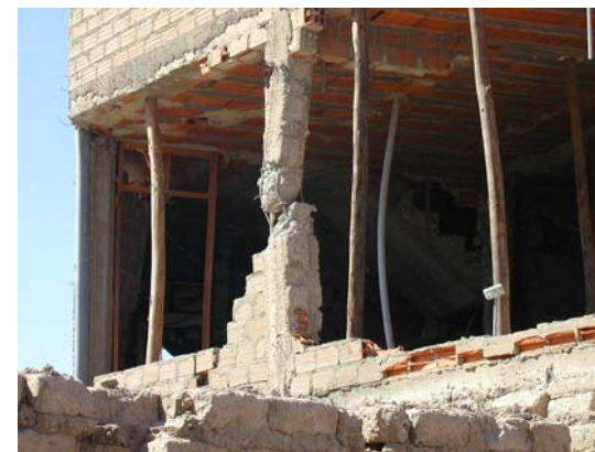
VIVIENDA CON PORTICOS FLEXIBLES Y MUROS CON LADRILLO PANDERETA FOTO EDUARDO FIERRO(CIP)
