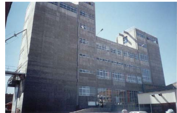
EDIFICIO INDUSTRIAL DE 9 PISOS SIN DAÑOS POR ADECUADA ESTRUCTURACION Y CALIDAD DE CONSTRUCCION FOTO ANTONIO BLANCO (CIP)
