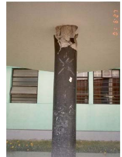
FALLA EN LOS EXTREMOS DE UNA COLUMNA
