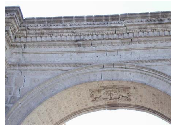
DETALLE DE ARCO DE SILLAR EN LA PLAZA DE ARMAS FOTO EDUARDO FIERRO (CIP)
