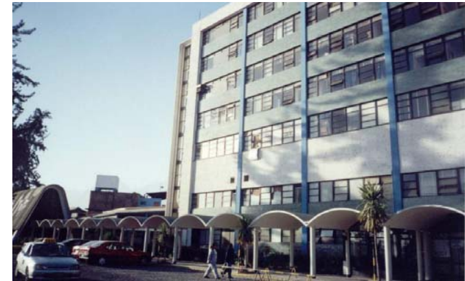
HOSPITAL DE ESSALUD CONSTRUIDO EN 1960 SIN DAÑOS EN LA ESTRUCTURA PERO CON DAÑOS EN LA TABIQUERIA INTERIOR FOTO ANTONIO BLANCO (CIP)
