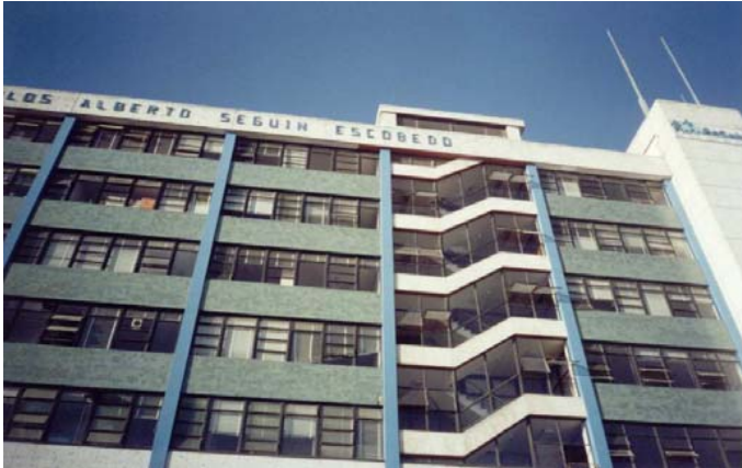
HOSPITAL DE ESSALUD CONSTRUIDO EN 1960 SIN DAÑOS EN LA ESTRUCTURA PERO CON DAÑOS EN LA TABIQUERIA INTERIOR FOTO ANTONIO BLANCO (CIP)
