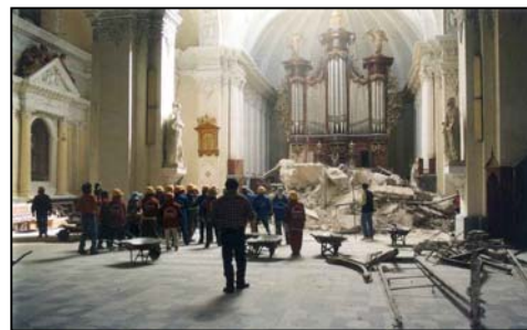
Foto 20. La torre izquierda de la Catedral de Arequipa perforó el techo al caer.
