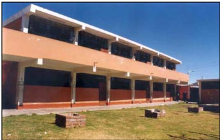
Foto 26. Pabellón tradicional aptoricado sin daño gracias al muro de cierre longitudinal
