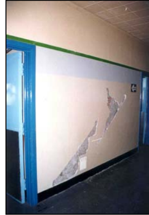
Foto 12. Los tabiques del Hospital Carlos Alberto Segúin controlaron los desplazamientos laterales y disiparon energía.
