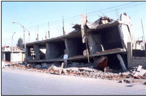
Fotos 15 y 16. Viviendas colapsadas de tres pisos en albañilería y concreto, Tacna.
