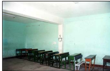
Foto 27. Muro de cierre que controló el desplazamiento lateral y evitó el problema de columna corta en un pabellón aptoricado tradicional.
