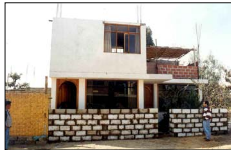
Foto 18. Vivienda sin daños a pocos metros de otra con daño irreparable.
