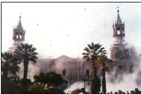
Foto 19. La catedral de Arequipa instantes antes de la caída de una de sus torres.
