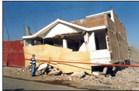
Fotos 15 y 16. Viviendas colapsadas de tres pisos en albañilería y concreto, Tacna.
