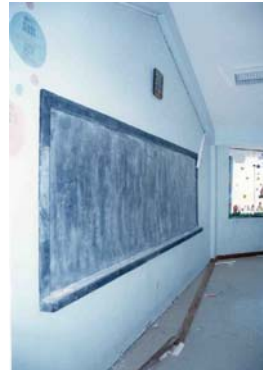
Foto 5. Vigas y columnas separadas de los elementos no-estructurales, Colegio Santa Fortunata, Moquegua.
