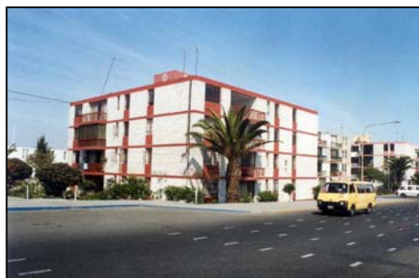
Foto 24. Edificio de departamentos muy rígido y antiguo sin daños, Tacna.
