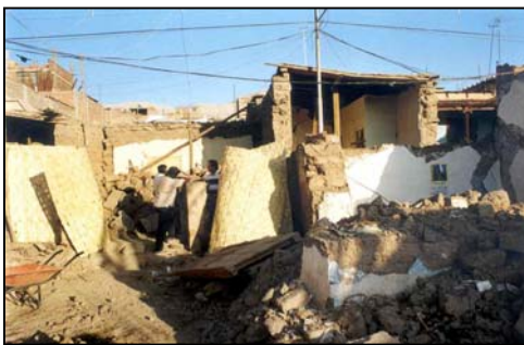
Foto 13. Colapso de viviendas de adobe en Moquegua
