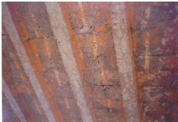
Foto 4. Condición del aligerado para el ensayo 3
