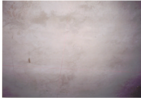
Foto 3. Condición del aligerado para el ensayo 2
