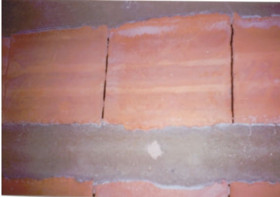
Foto 2. Condición del aligerado para el ensayo 1
