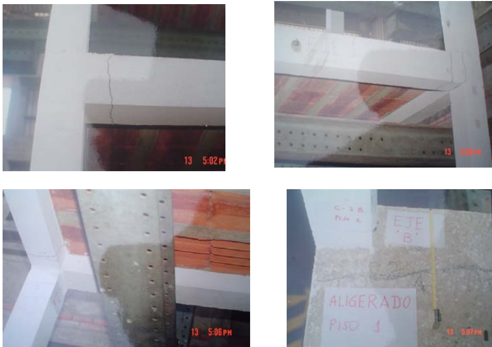
Fig.6. Nudos del nivel 1 y falla del aligerado con trituración de bloques.
