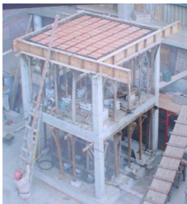
Fig.2. Construcción del módulo.
