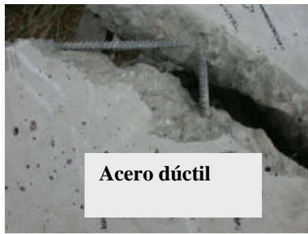
Fig.12 Inspección del refuerzo después del ensayo.
