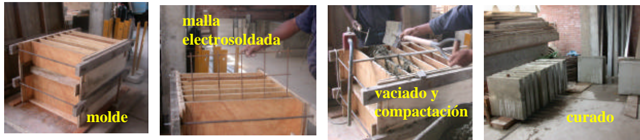
Fig.6. Secuencias de la construcción de los 18 muretes.
