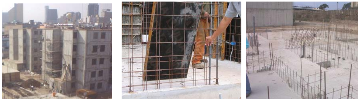
Fig.1. Edificio con muros delgados de concreto armado de ductilidad limitada.
