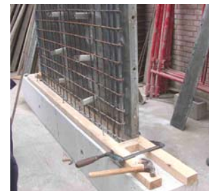
Fig.7 Encofrado en ME2 y RD2.
