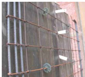
Fig.6 Encofrado en ME1 y RD1.
