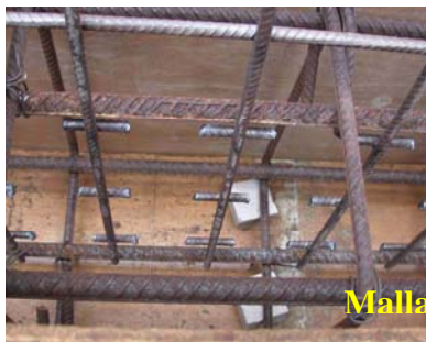
Fig.4. Detalles de anclaje del refuerzo vertical en la cimentación y la solera.
