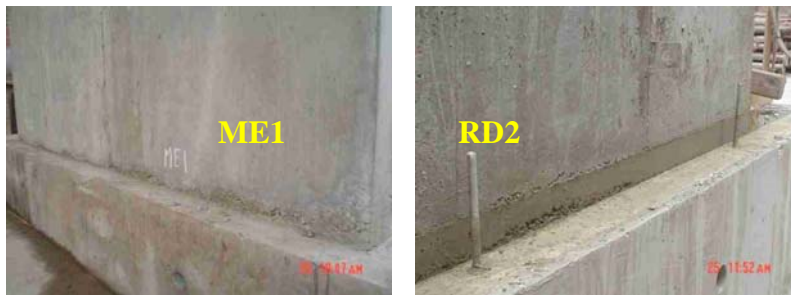
Fig.9. Segregación en la base de ME1 y RD2.
