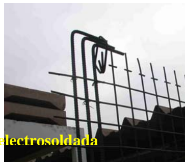
Fig.4. Detalles de anclaje del refuerzo vertical en la cimentación y la solera.
