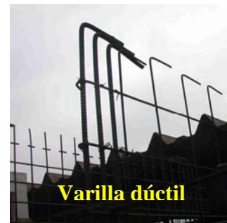
Fig.4. Detalles de anclaje del refuerzo vertical en la cimentación y la solera.
