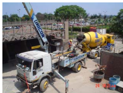
Fig.8 Vaciado y compactación del concreto.
