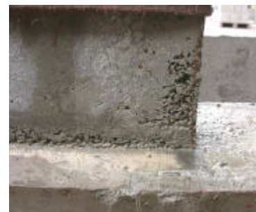
Foto 6. Desencofrado, ranura dejada por la corbata y segregación en la base de P1.
