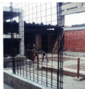
Foto 1. Refuerzo en la placa P1
