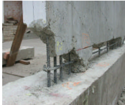
Foto 13. Placa P2. Inspección post-ensayo. Pequeño pandeo en las barras extremas (izquierda) y comportamiento adecuado de las varillas centrales (derecha).
