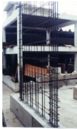
Foto 3. Refuerzo en la placa P3
