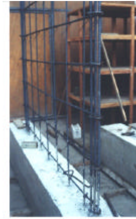
Foto 2 Refuerzo en la placa P2
