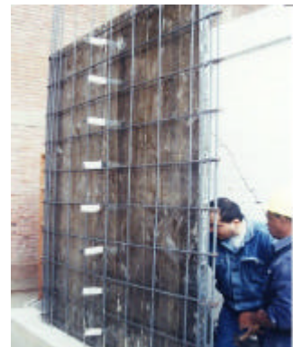
Foto 4. Corte del refuerzo horizontal en la franja de malla embutida en la cimentación de P1 (izquierda) y corbatas en la placa P2 (derecha).
