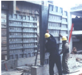
Foto 6. Desencofrado, ranura dejada por la corbata y segregación en la base de P1.
