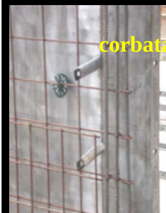
Conectores de tableros paralelos (corbatas en la unión de 2 tableros)
