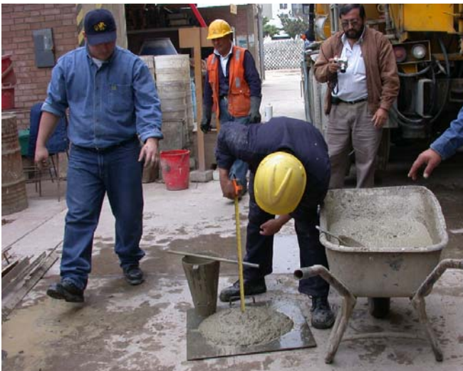
El concreto que se utiliza es premezclado rheoplástico, con slump = 10" y baja relación a/c f'c (mín) = 175 kg/cm 2 preparado en Mixer y vaciado con Bomba
