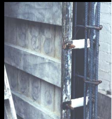
Conectores de tableros paralelos (corbatas en la unión de 2 tableros)
