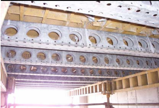
Encofrado EFCO para techos
