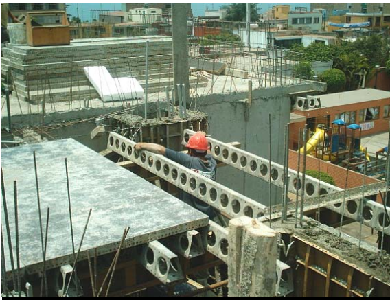
Encofrado EFCO para techos
