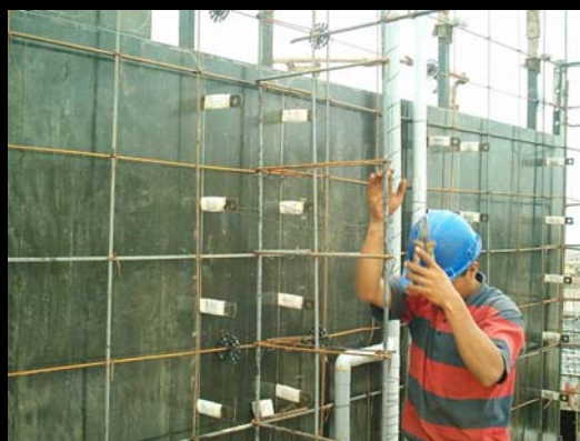
Conectores de tableros paralelos (corbatas en la unión de 2 tableros)
