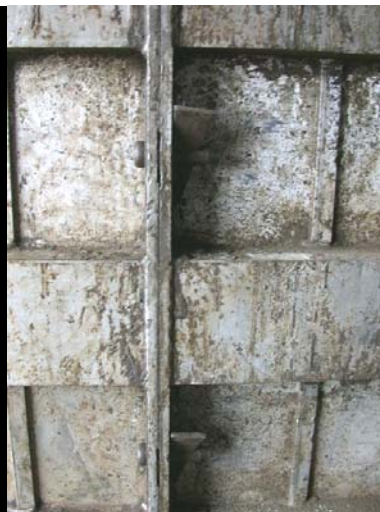
Conectores de tableros paralelos (corbatas en la unión de 2 tableros)
