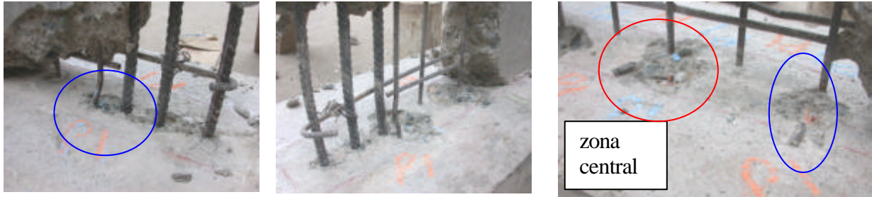
Foto 5. Inspección post-ensayo de la placa P1. Pandeo de la barra vertical extrema y cizalle de las varillas verticales de la malla electrosoldada embutida en la cimentación.
