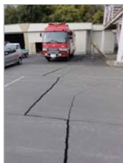
Daño extenso en pavimentos
