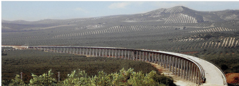
Viaducto de Archidona. 3.150 m de dintel mixto sin juntas de dilatación L.A.V. Antequera - Granada
