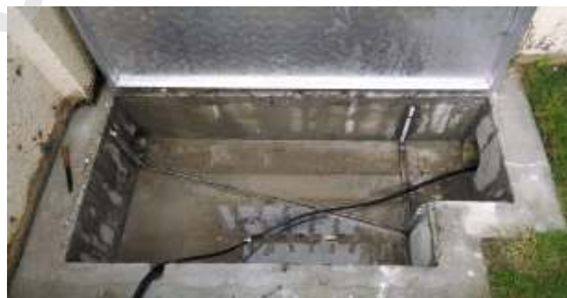
Construcción de registros para control de flujo de escorrentía
