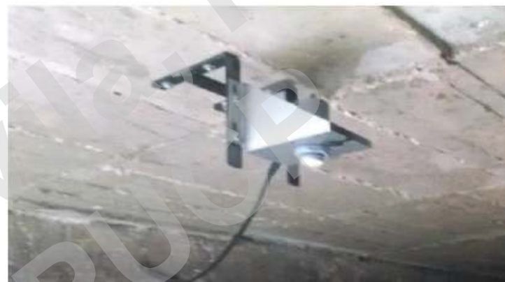
Instalación de sensores de niveles y caudales
