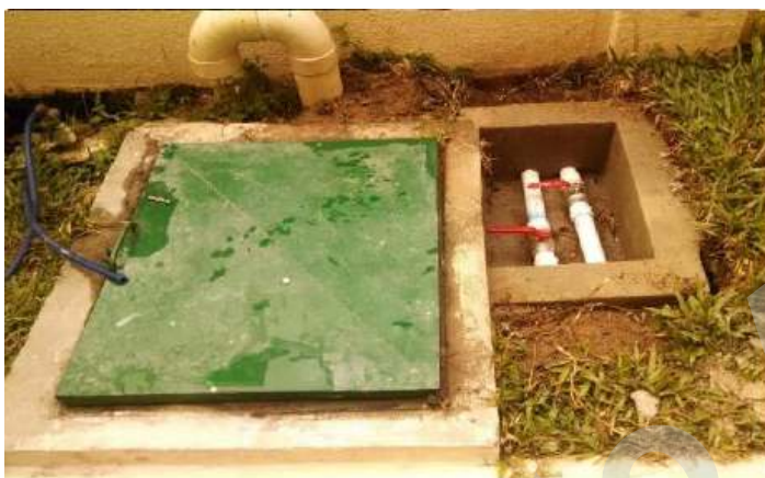
Tuberías en tanque de almacenamiento para conducción de agua hacia jardín y calle
